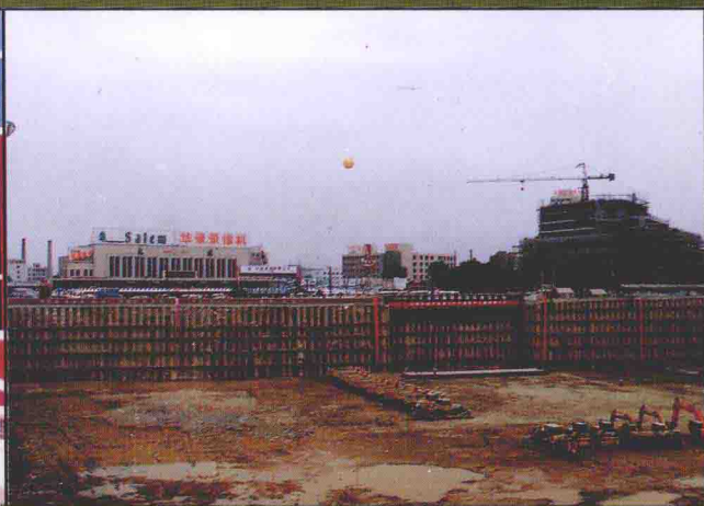
大連市站前不夜城土石方施工現場
