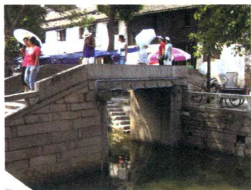
► 太平桥，建于清乾隆十二年（公元1747年），桥为梁式，横跨于东柳、漆字两圩
