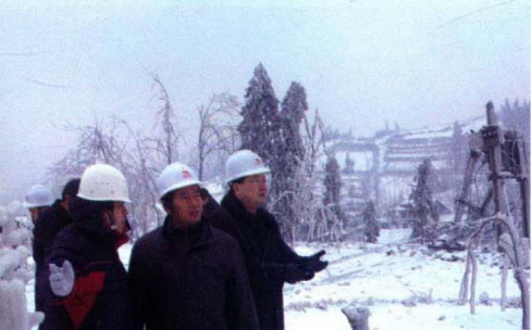
县长樊昌林(中),县委常委、常务副县长刘隆俊(右一)在电网抢修现场检查工作进展情况
