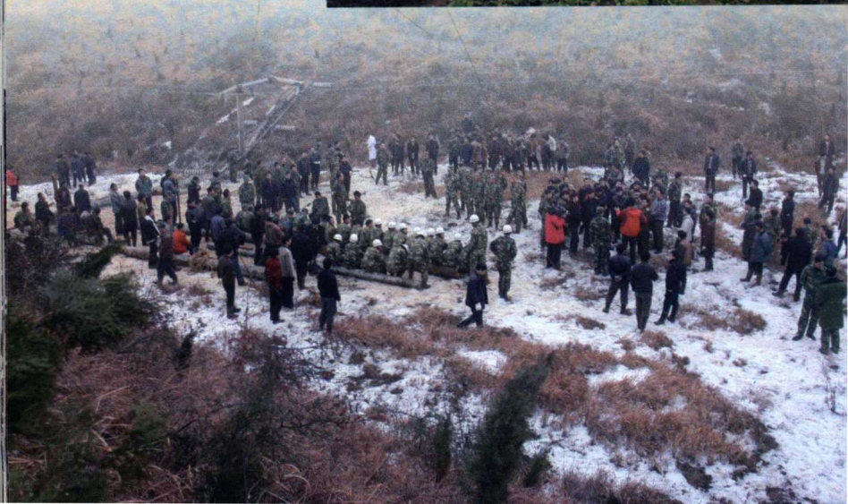
电力技术人员在栽杆架线
