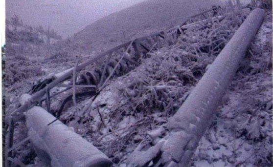
被冰雪压塌的国家电网基杆
