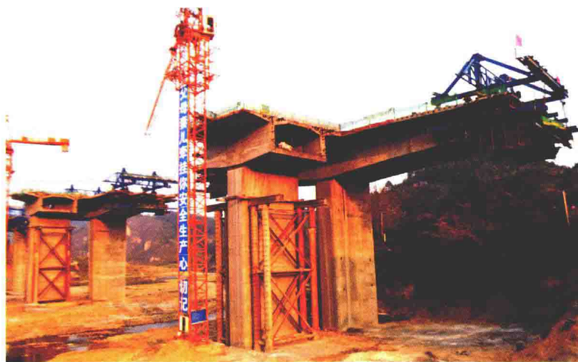
滨江大道桥梁施工中
