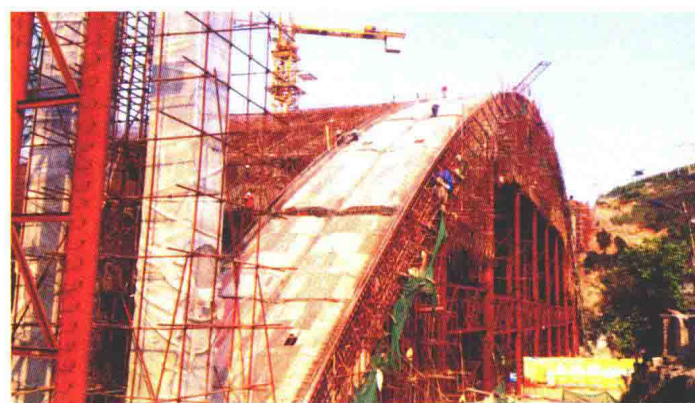
施工中的清水江大桥
