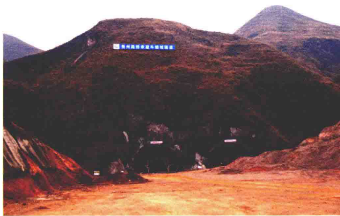
滨江大道隧道工程施工中
