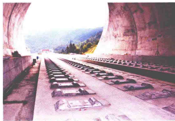
贵广快速铁路榕江段无砟轨道
