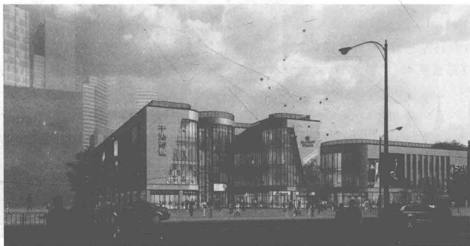
图 1-12 大量性建筑——大型商场
