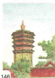
146 河南安阳文峰塔
