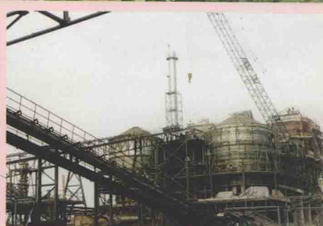
在建的广西鹿寨 24 万吨磷铵工程
