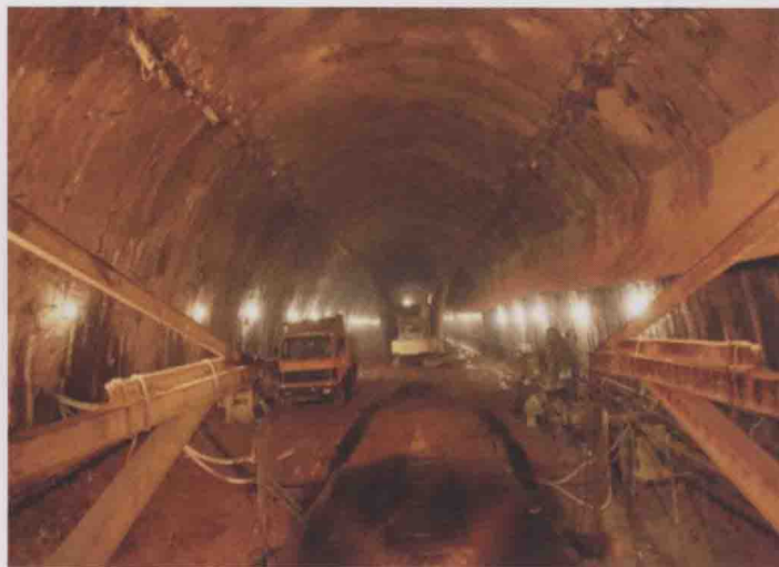
图 1.1.3 钻爆法隧道概略图
