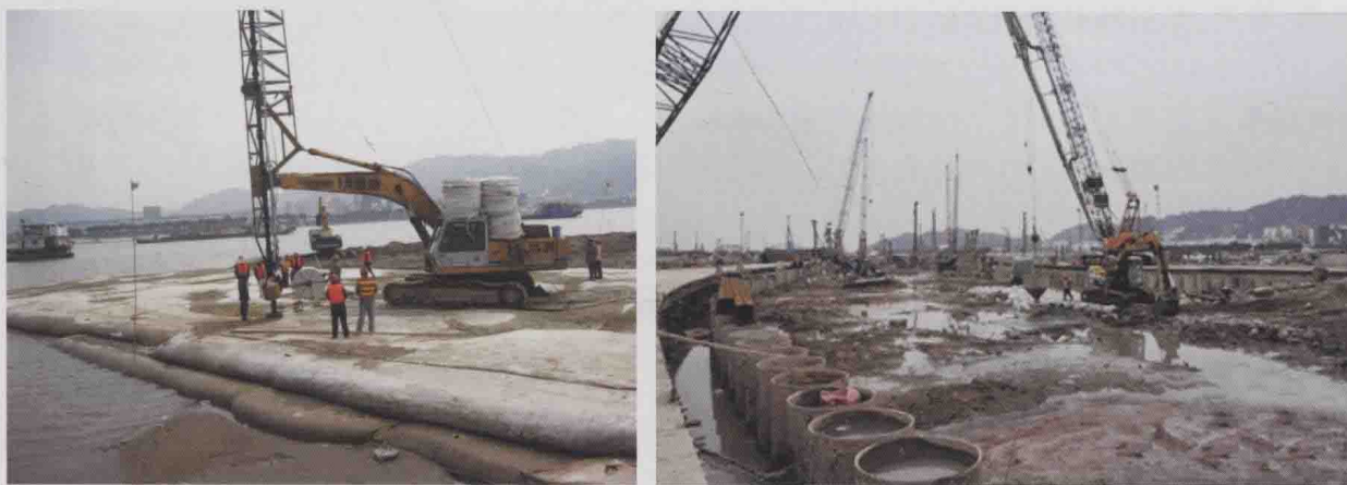
图 1.1.4 围堰明挖法隧道概略图
