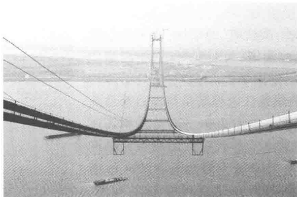
图 1.5 润扬长江公路大桥
