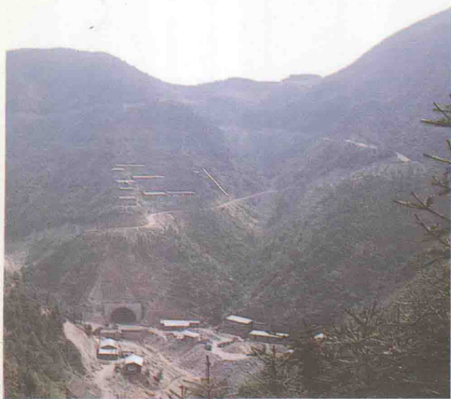
施工中的龙门岭公路隧道
