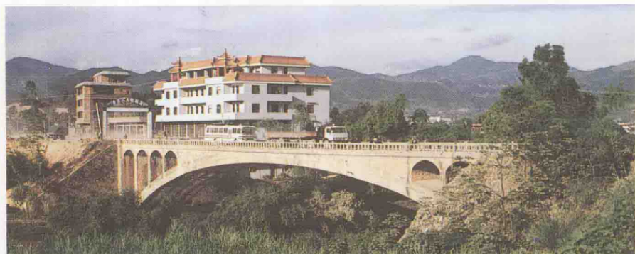
泉州市跨径最大的英溪桥
