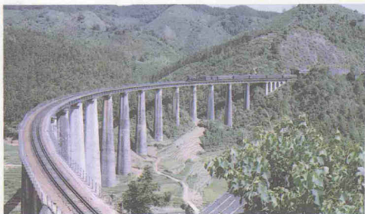
尾厝铁路大桥
