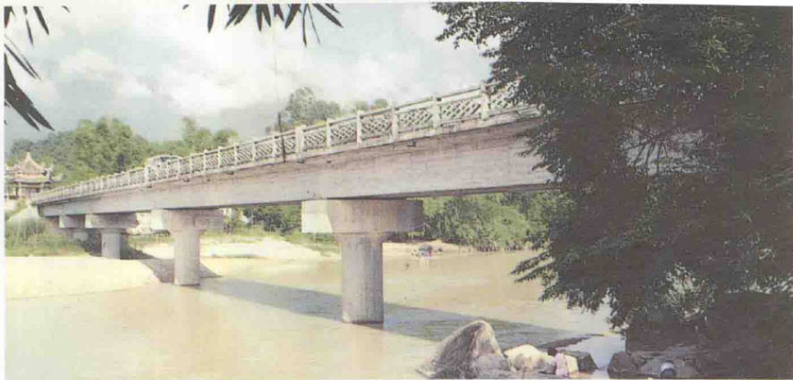
首次采用单柱式桥墩建造的龙门榜头大桥
