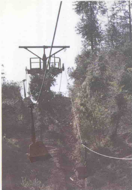
潘田铁矿运输索道
