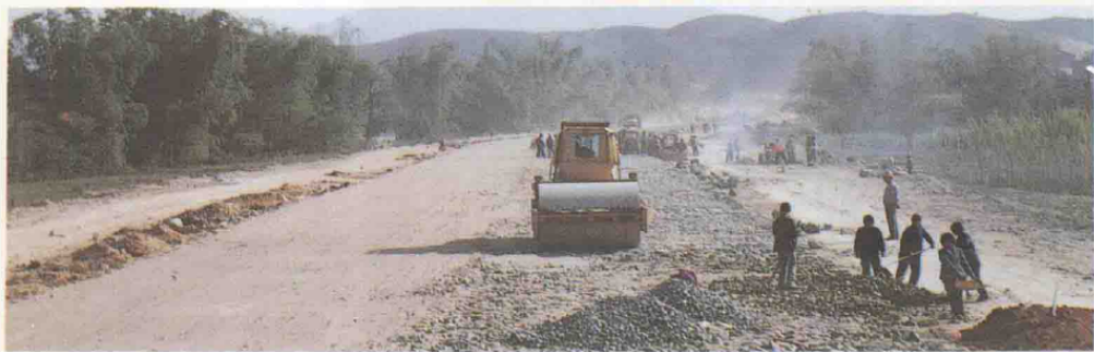
扩建施工中的泉安公路安溪路段雏形
