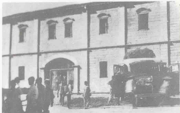
安溪民办汽车路股份 有限公司龙门车站旧址
