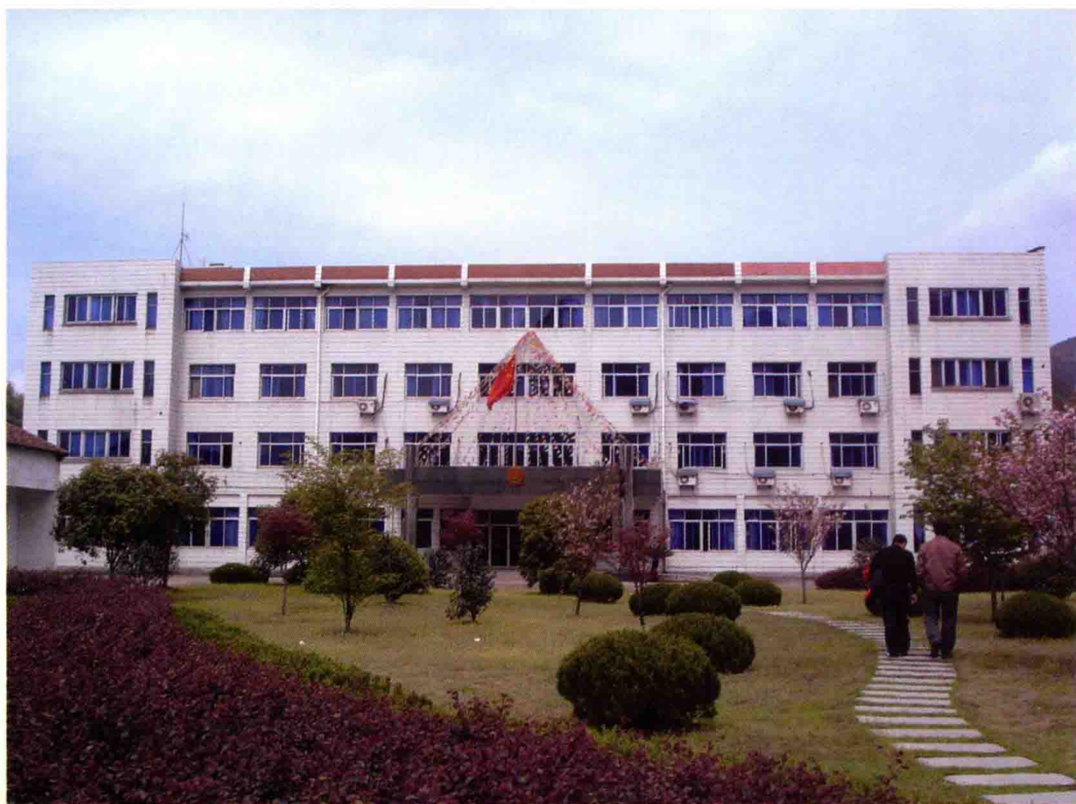
稽东镇政府办公大楼
