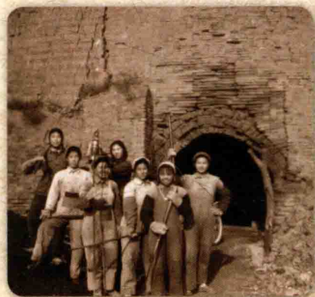
▲ 全民挖防空洞自己烧砖
