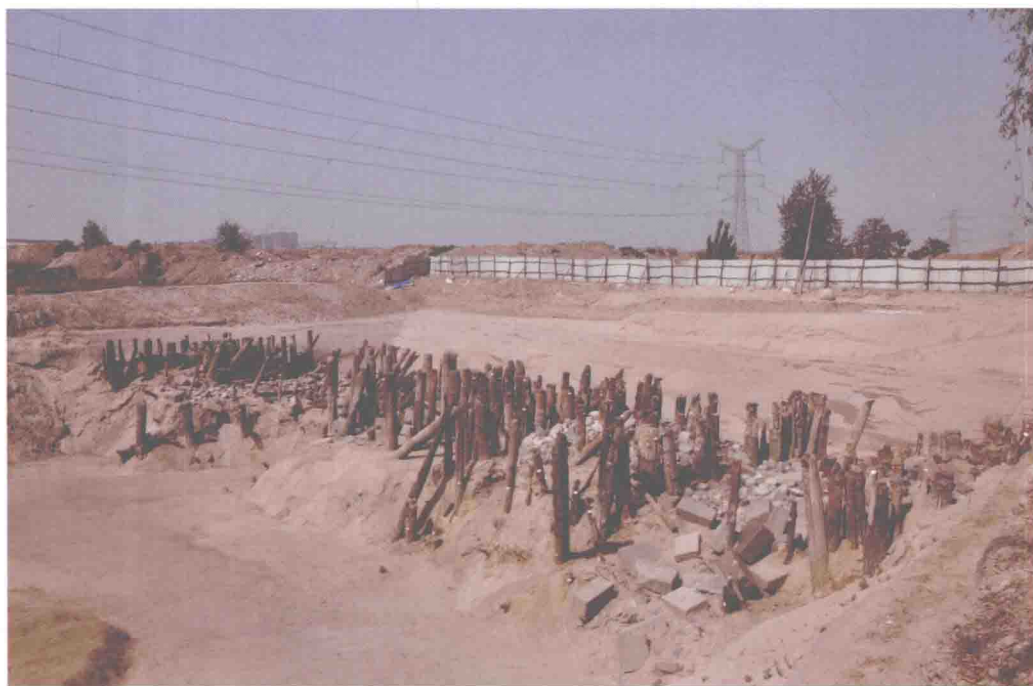
陕西西安西汉长安城渭桥遗址——厨城门一号桥（由西南向东北）
