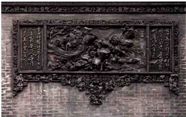
首进东路外墙
