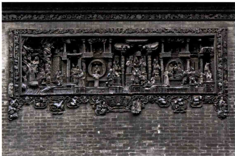
首进东路外墙
