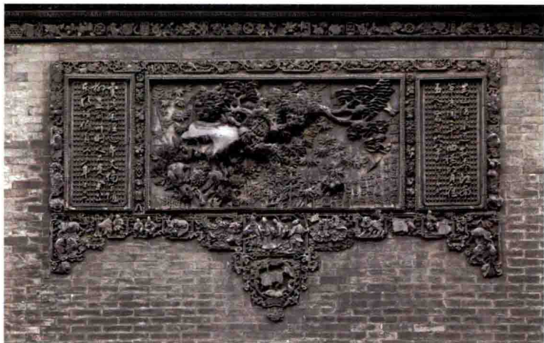
首进东路外墙
