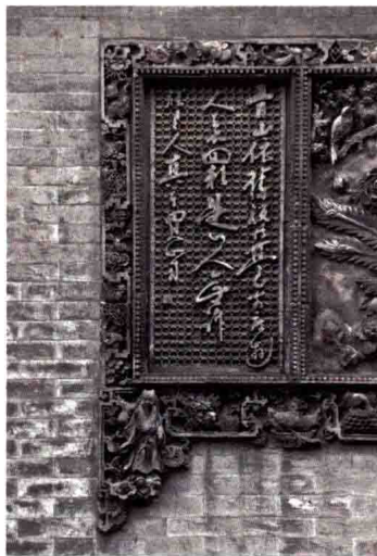
首进东路外墙
