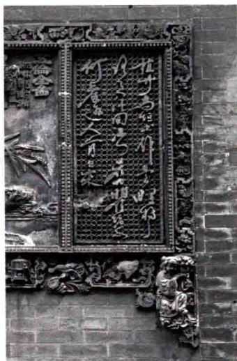
首进东路外墙
