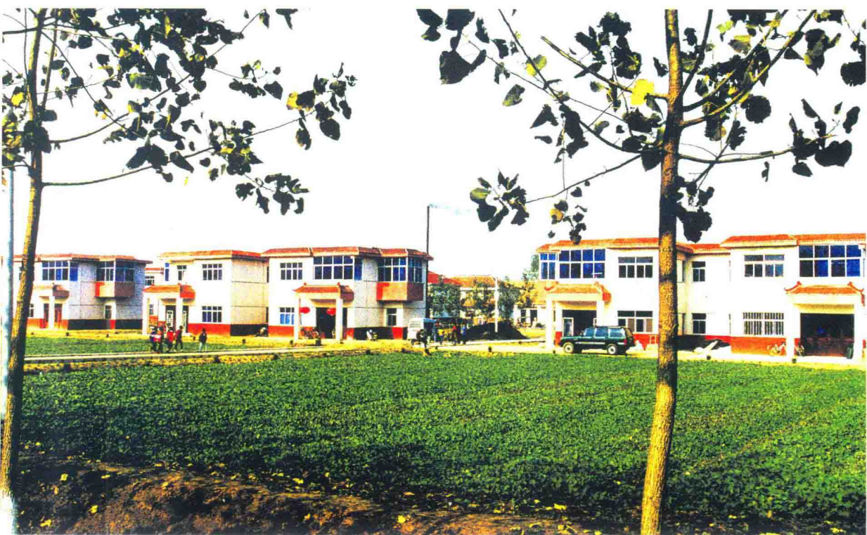
淮河入海水道移民新居
