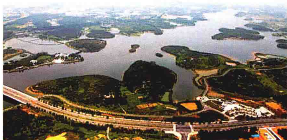
东莞市松木山水库（摄于2006年9月7日）
