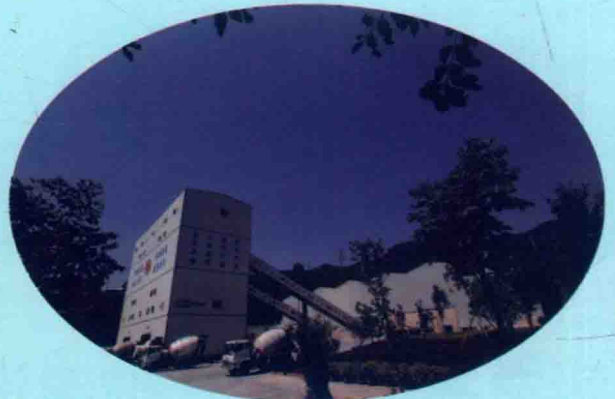
西城区搅拌站
