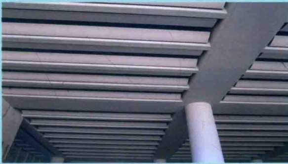
机场清水混凝土
