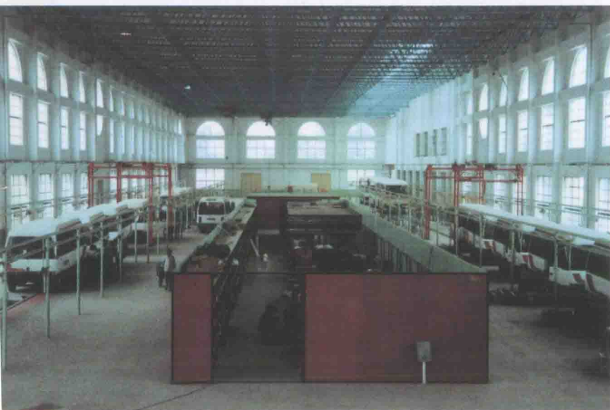
聊城客车厂多跨式联合厂房
