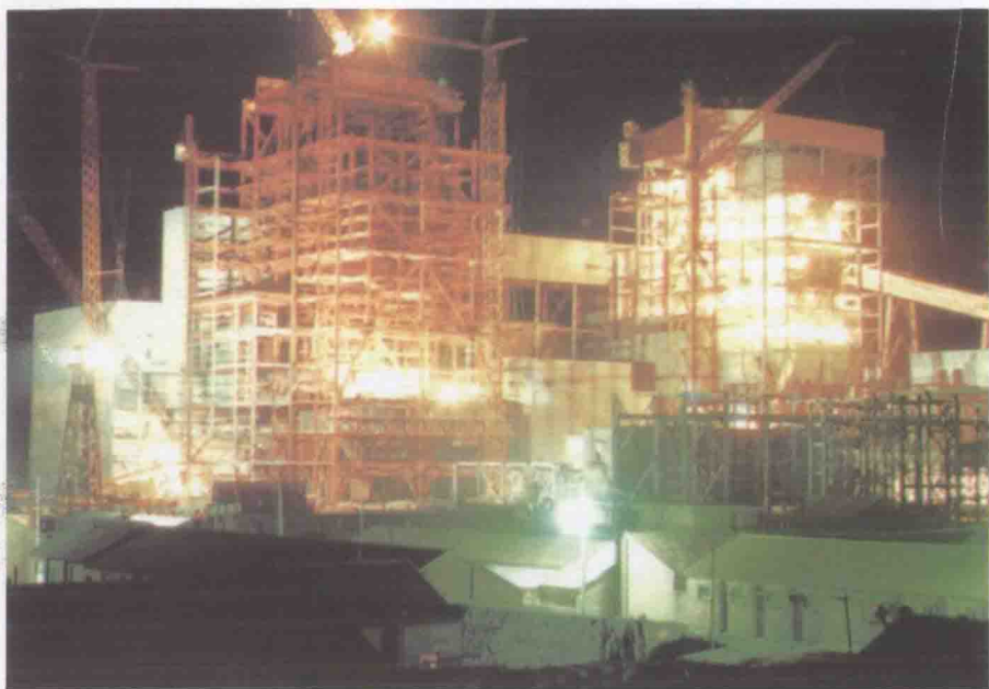
建设中的石横电厂
