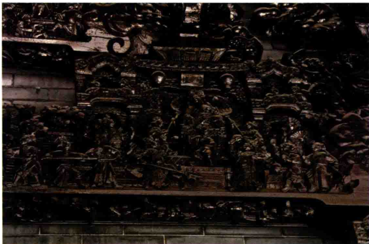
首进正门东面梁架
