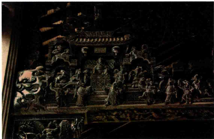
首进正门西面梁架
