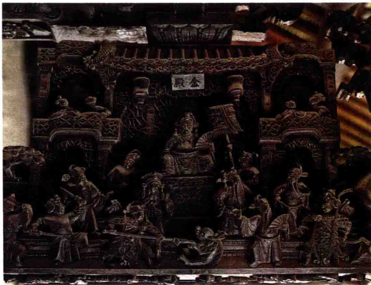
首进正门西面梁架
