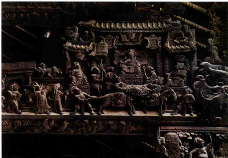
首进正门东面梁架
