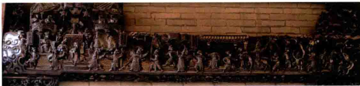
首进正门西面梁架
