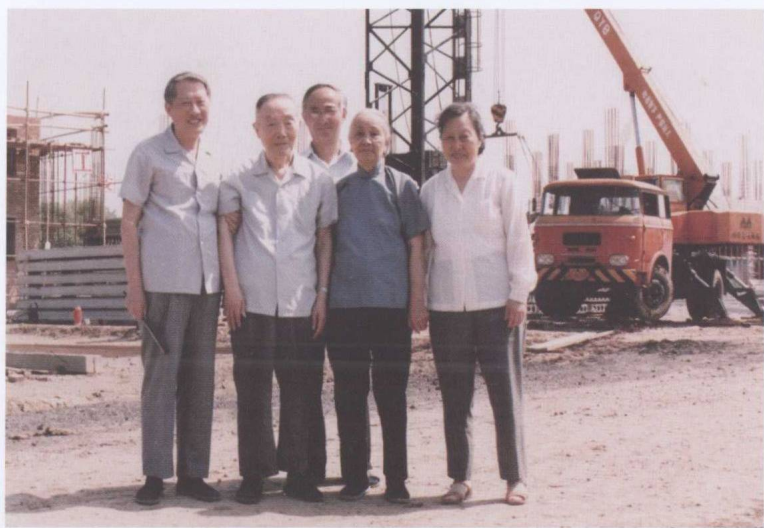
晚年十分关心中国科学院心理研究所新所址的建设，图为潘菽（左二）在建筑工地现场。（摄于1986年夏）
