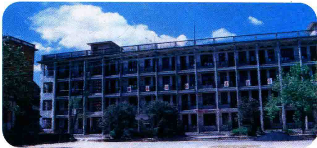
永州市第一小学教学楼
