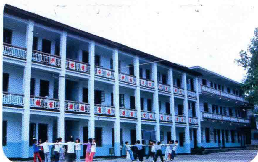
冷水滩市第三小学教学楼
