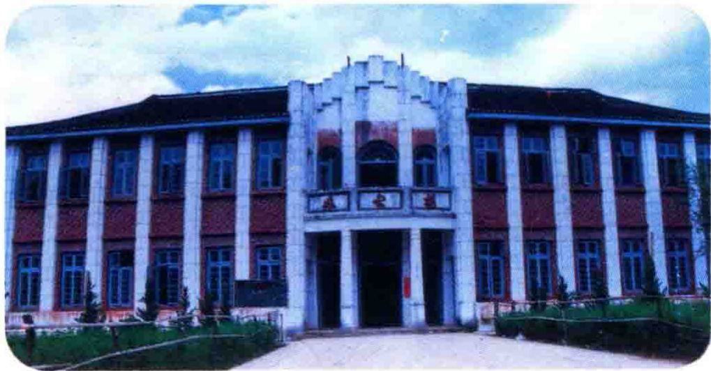
永州市一中办公大楼
