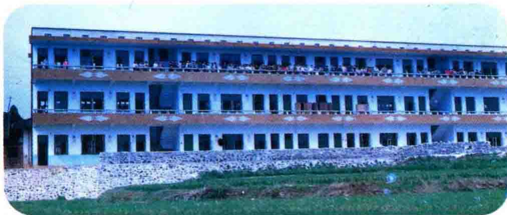
冷水滩市普利桥区中学教学楼
