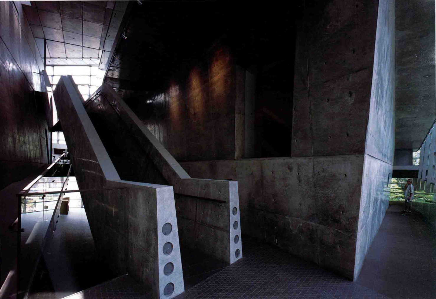
倾斜5°的清水混凝土斜墙面包围了斜坡。 左边是连接四层和三层的预应力混凝土楼梯
