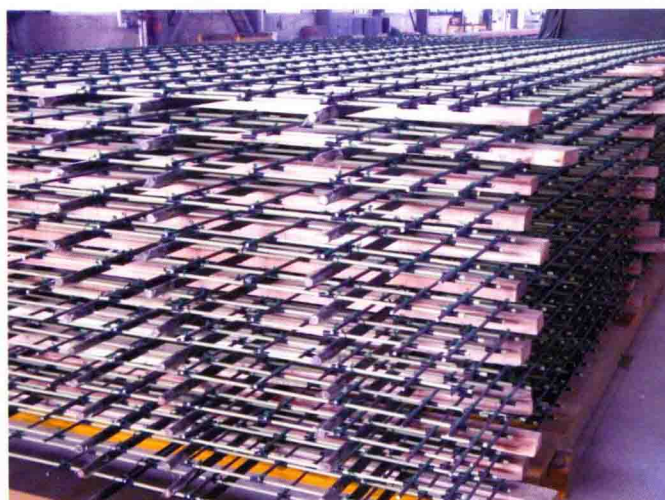
钢筋网片存放
