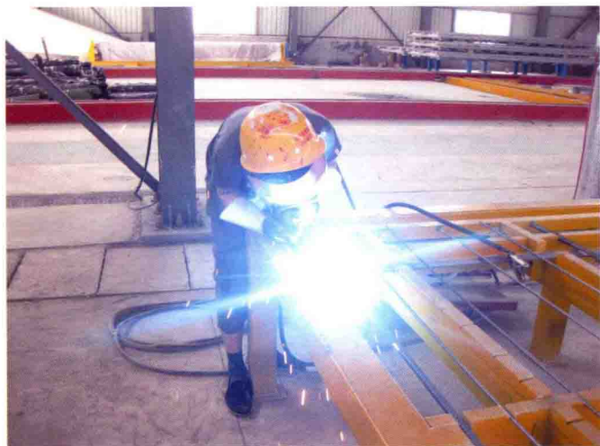
接地端子焊接
