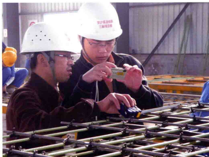
绑扎钢筋间距检查
