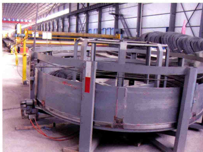
预应力钢筋加工
