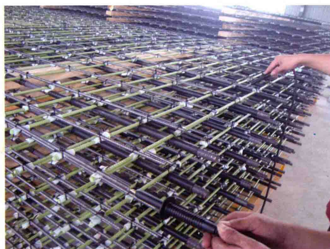
钢筋网片绝缘检测
