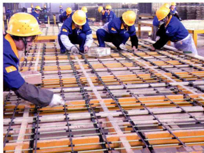
钢筋网片绑扎
