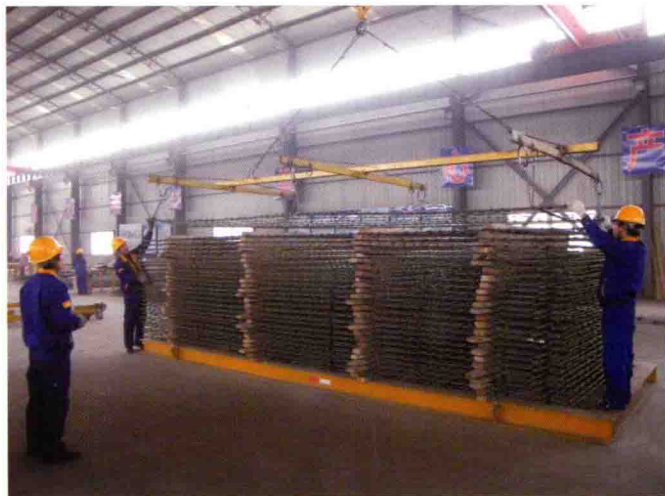
钢筋网片吊装
