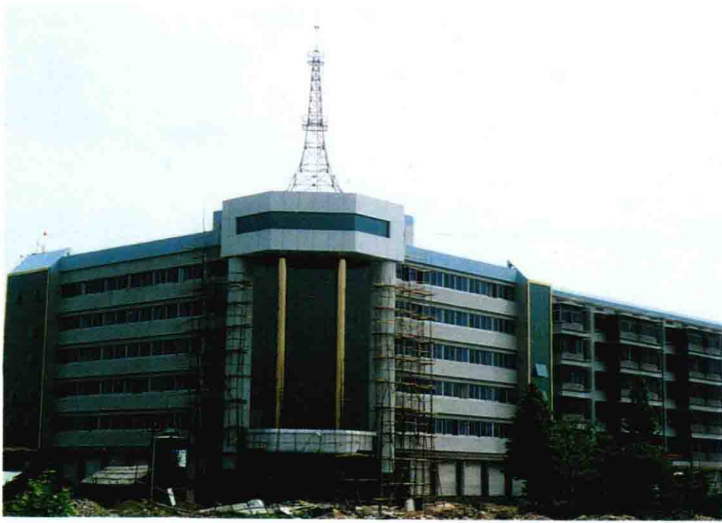
在建中的上虞市水利局办公楼
