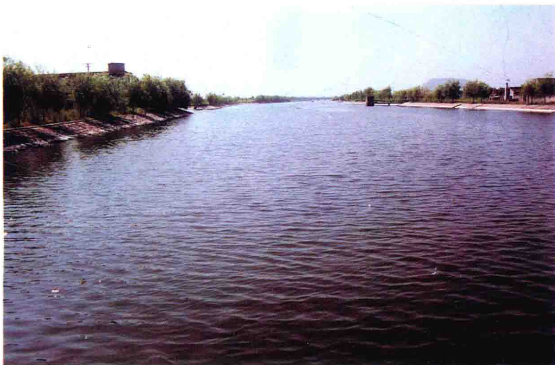
东进闸排涝干河
