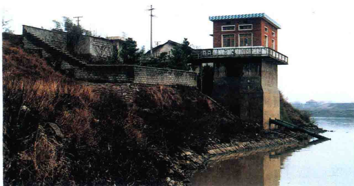
石山庙灌溉站
