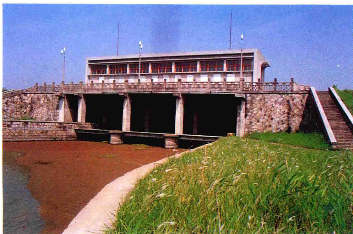
西大堤一号闸
