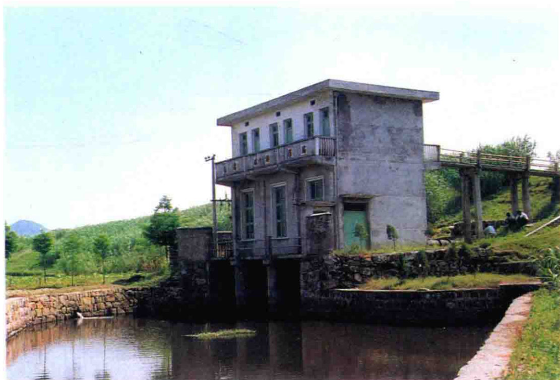
张龙坝排涝站
