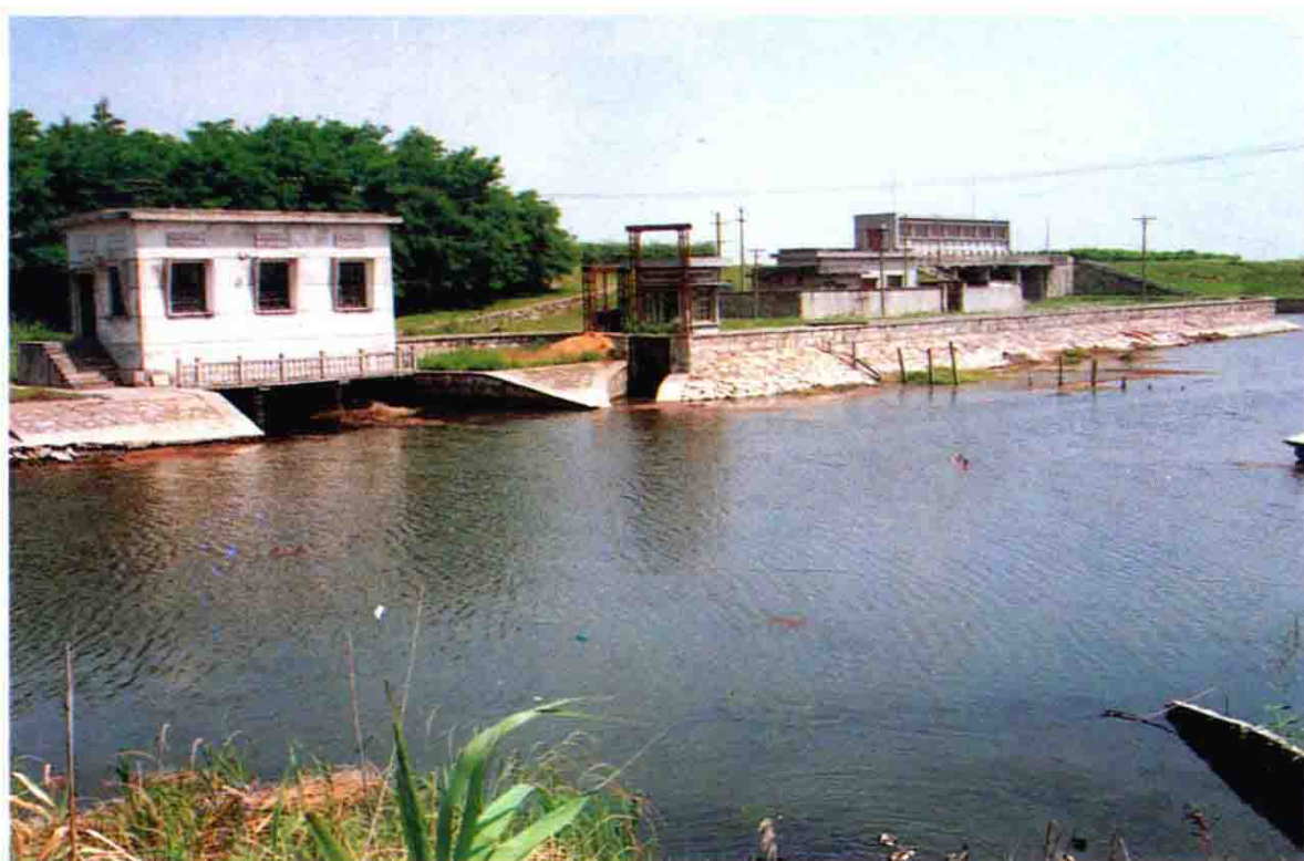
西大堤一号闸冲淤泵站
