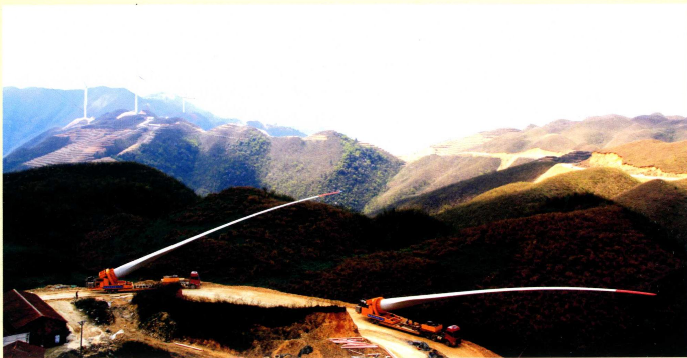
建设中总投资4亿元的锦屏青山界风力发电项目一期工程实施现场
