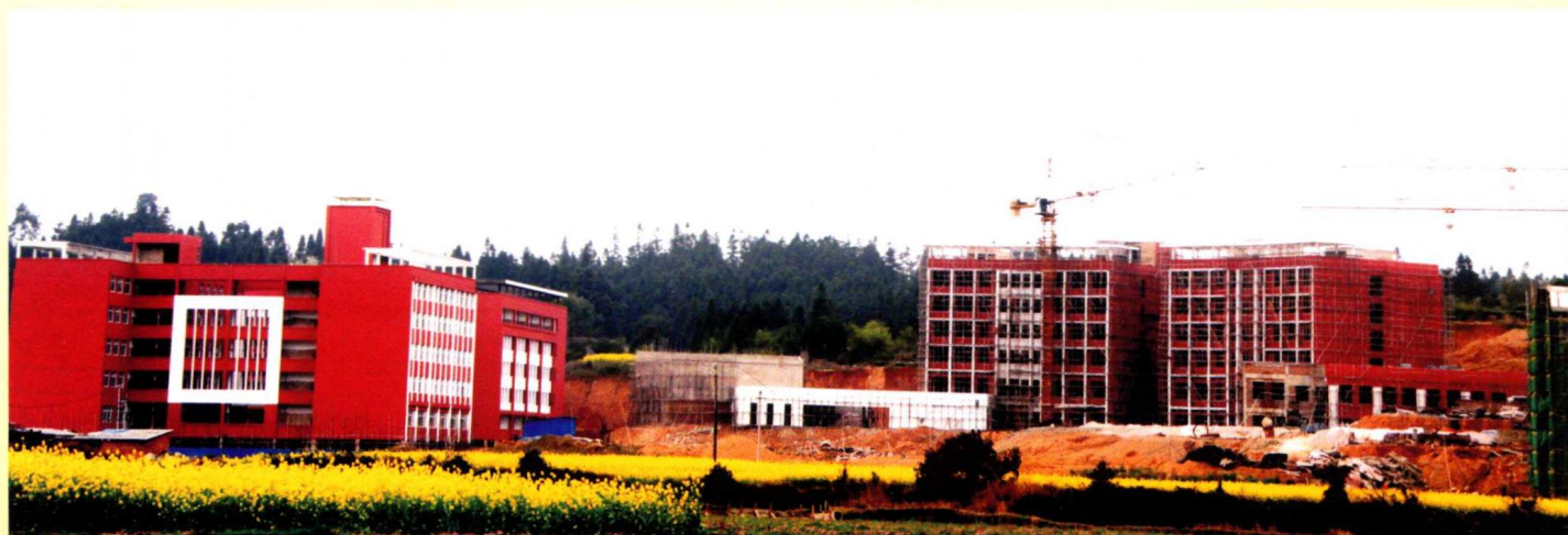
建设中的县中等职业技术学校新校区（敦寨）
