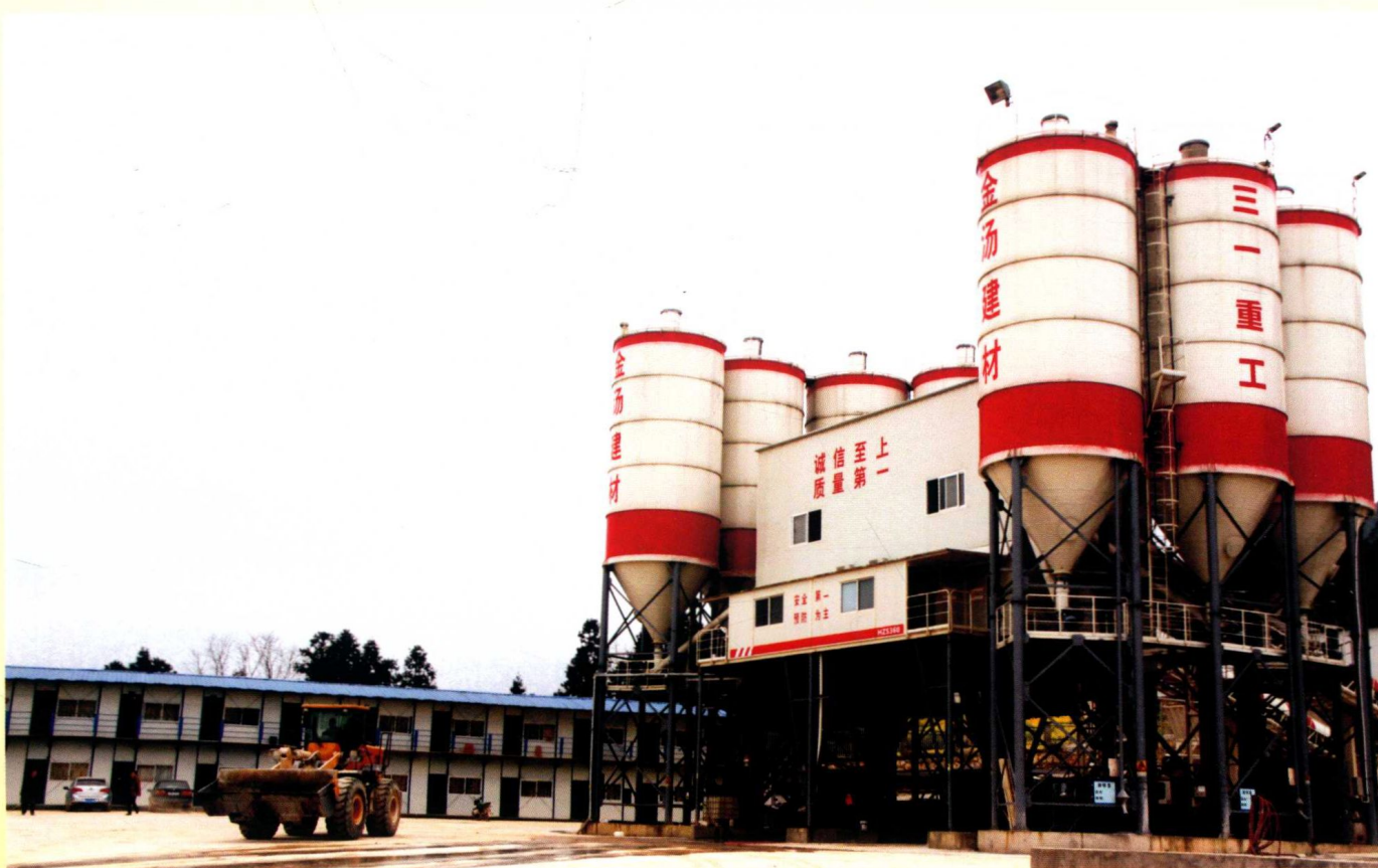
招商投资八千万元建成投产的浩天伟业混凝土有限公司生产车间
