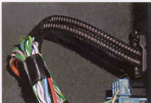
图 4-17 光缆防弯曲保护
