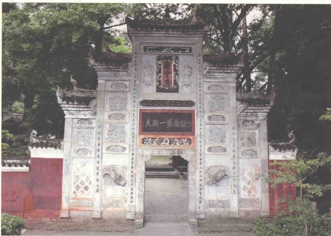
黄平县飞云崖古建筑群（山门牌楼）
