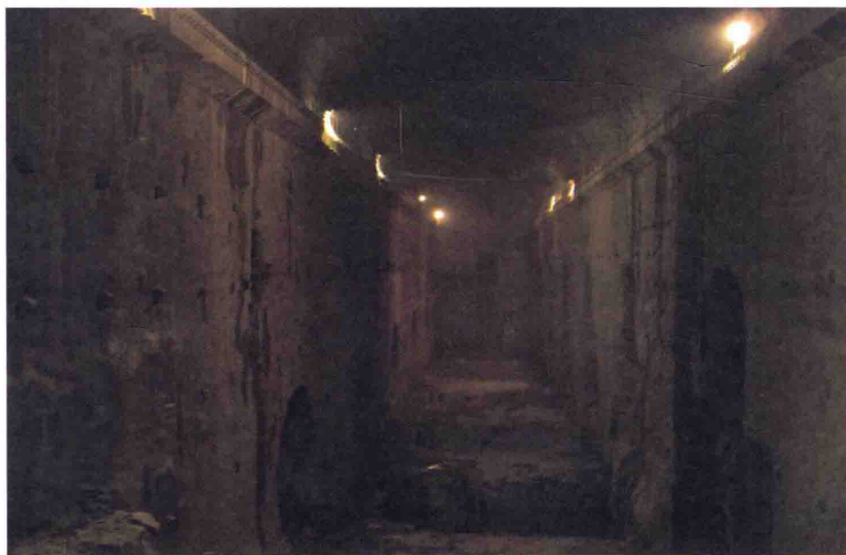
图 1.3 三峡工程地下电站硐室
