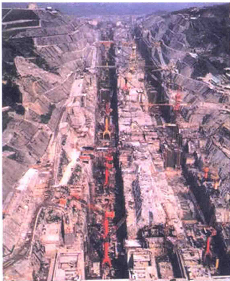
图 1.1 三峡工程永久船闸开挖施工现场
