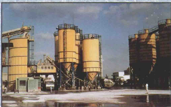
上海建工材料公司长桥搅拌站
