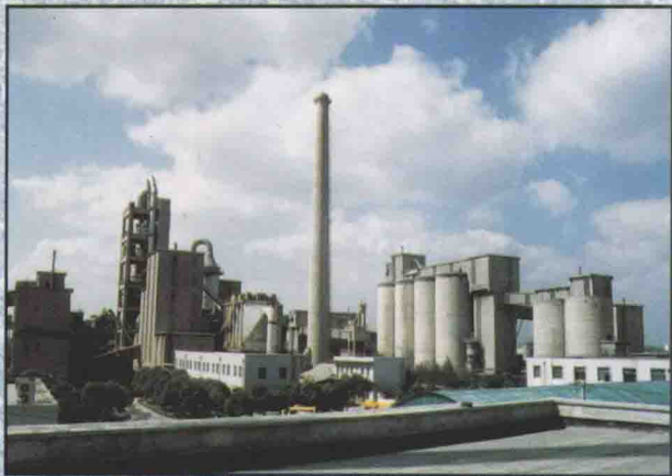
1987年6月11日建成的上海川沙水泥厂
