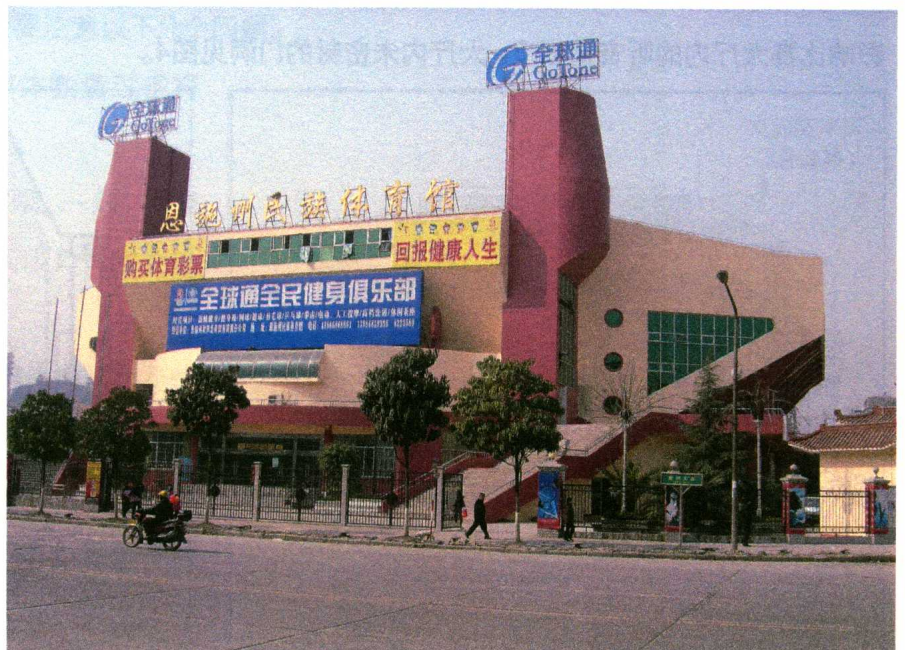
图1 恩施州民族体育馆建筑造型
