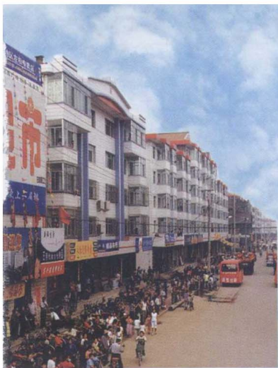
县城辽阳街居民住宅小区
