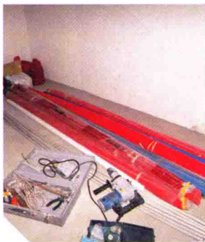
05 水电材料购置齐全，运输至施工现场进场
