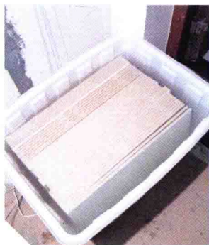
10 瓷砖浸泡、晾干后备用， 调配水泥砂浆
