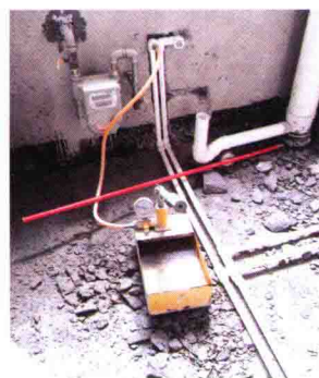
07 水电管线测试、验收，线槽封闭
