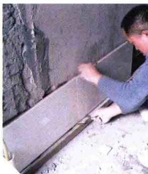
11 瓷砖铺装，勾缝，验收
