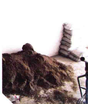
09 瓷砖、水泥、砂等材料进场，放线定位
