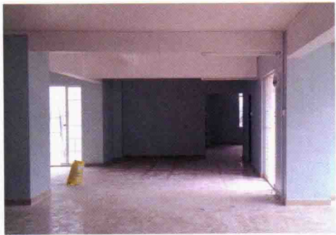
图 1-20 打扫施工现场
