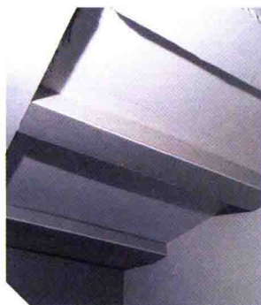
13 制作石膏板吊顶、木质 家具，验收
