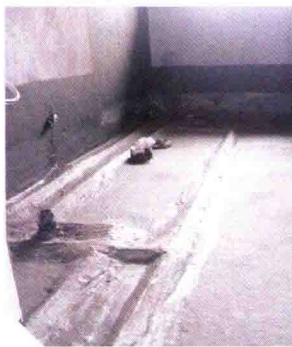
08 卫生间回填，制作防水，浸水测试
