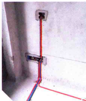
06 水电放线定位、开槽、布线、埋设暗盒
