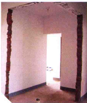
02 墙体构造拆除，墙体补充砌筑
