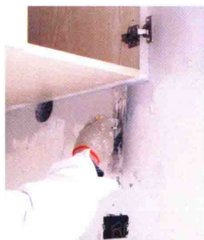
15 石膏粉修补，刮腻子， 打磨找平
