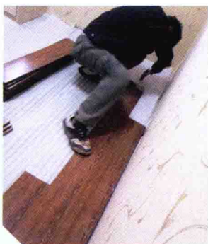
17 水电、成品构造安装， 验收
