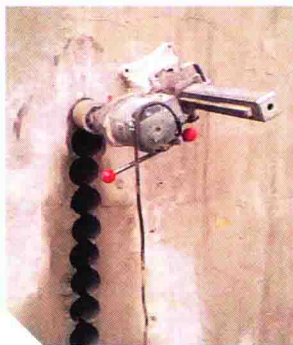
03 钻孔，根据需要更换门窗等建筑构造
