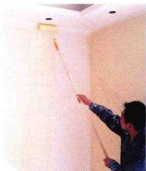
16 墙顶面刷乳胶漆，家具 刷木器漆，验收
