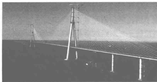
图 1.2-2 苏通长江公路大桥(中国,主跨 1 088m)
