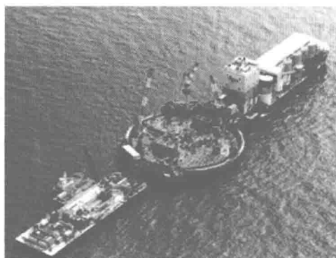
图 1.4-2 明石海峡大桥沉箱基础
