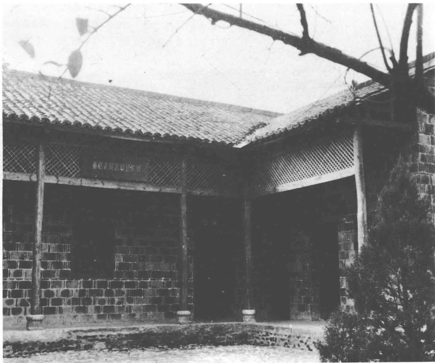
故居院内。董必武就诞 生在右侧左边的那间房 子里。
