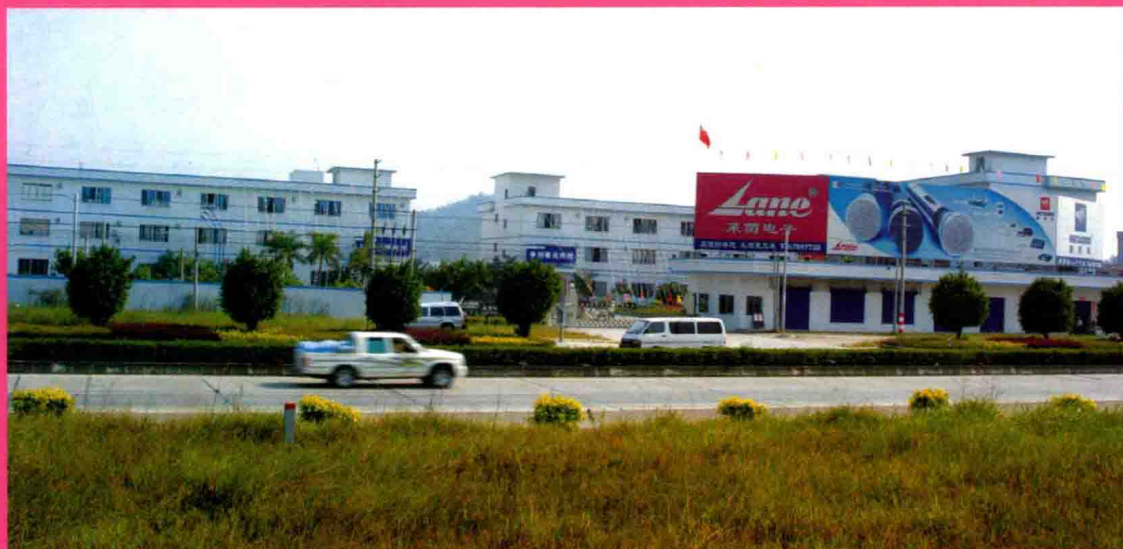
2002年，恩平市莱茵电子新科技有限公司新厂房建成投产。
