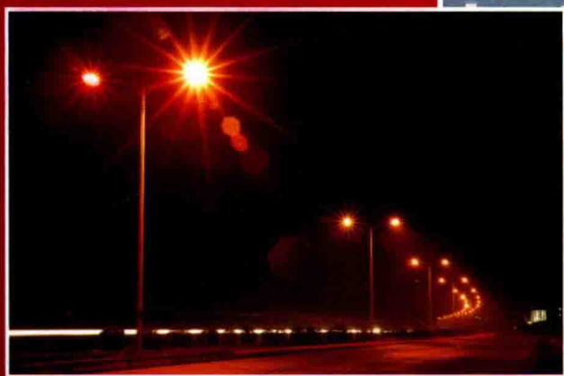
325国道横穿恩平市麦克风工业功能区。近年来，该区加强基础设施建设，全境安装了路灯。
