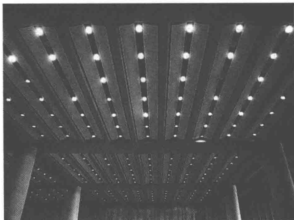
图3 行李提取大厅的清水混凝土施工技术
