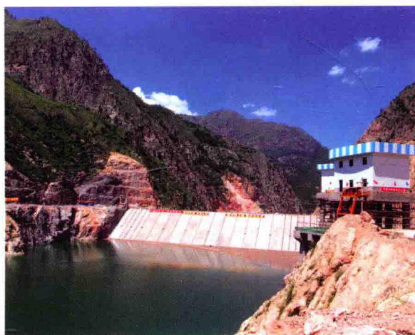
甘肃九甸峡水利枢纽工程混凝土面板堆石坝
