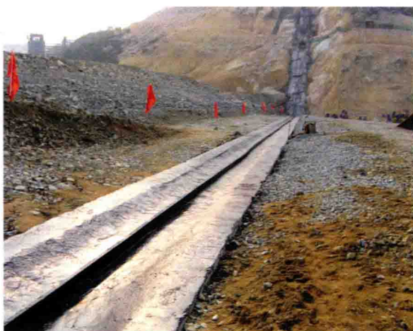
广东阳江核电水库沥青混凝土心墙底座施工玛蹄脂
