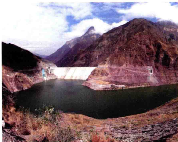
云南甲岩水电站混凝土面板堆石坝
