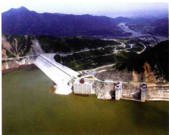
四川紫坪铺水利枢纽工程大坝上游鸟瞰图
