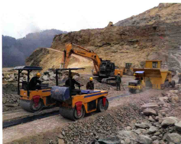
四川双桥水电站沥青混凝土心墙土石坝施工
