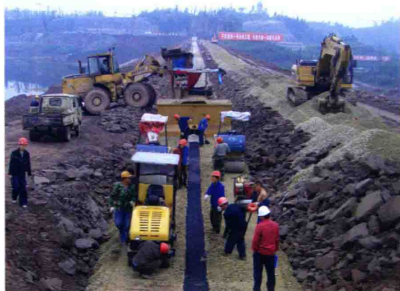
重庆玉滩水利枢纽沥青混凝土心墙土石坝基槽施工
