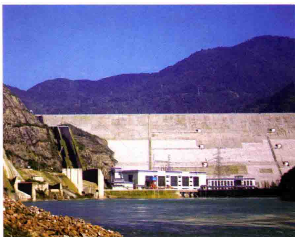
四川紫坪铺水利枢纽工程混凝土面板坝全景
