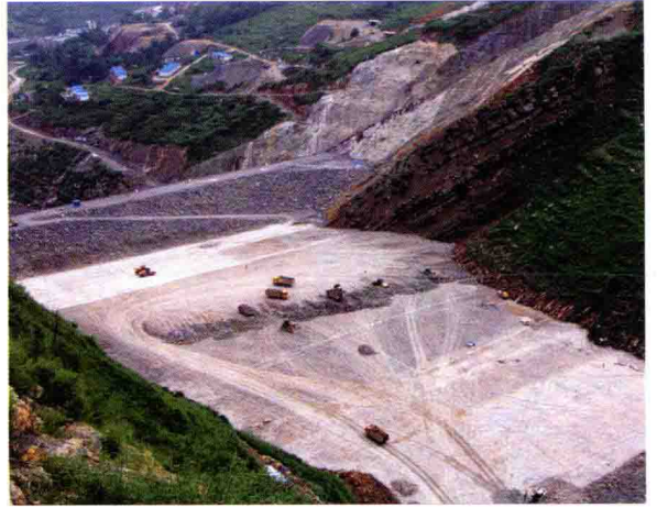
贵州黔中水利枢纽工程平寨混凝土面板堆石坝施工
