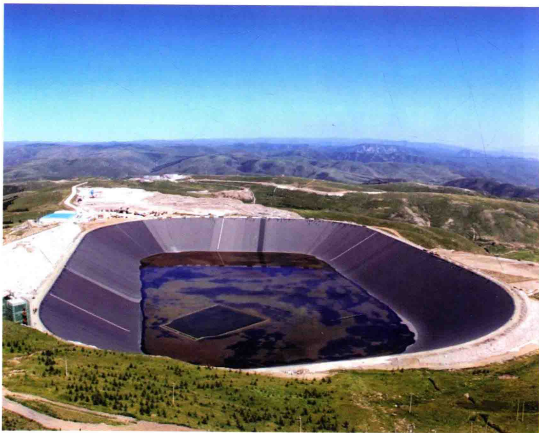
内蒙古呼和浩特抽水蓄能电站上库沥青混凝土防渗面板
