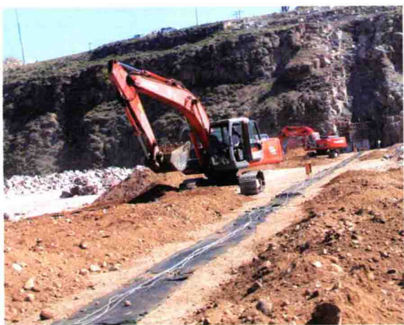
内蒙古三座店水利枢纽工程沥青混凝土心墙碾压施工
