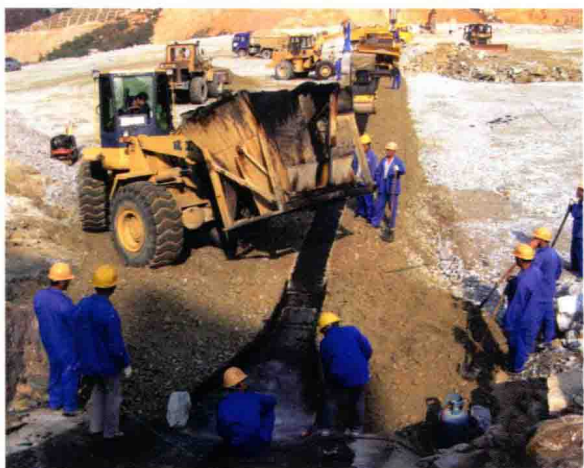
广东阳江核电水库沥青混凝土心墙坝肩施工
