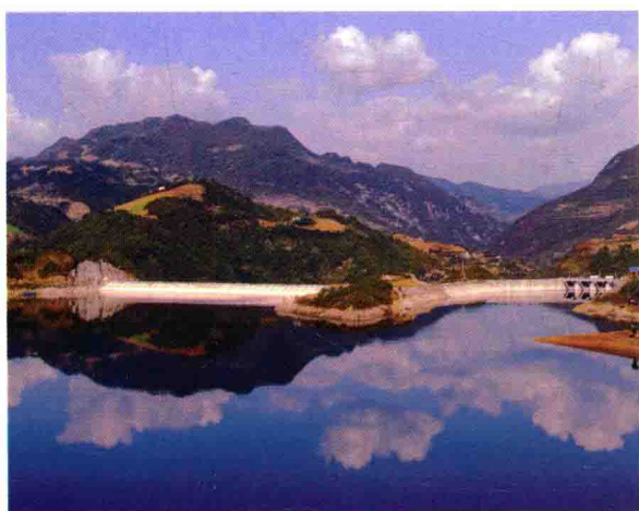
湖北寺平水电站混凝土面板堆石坝
