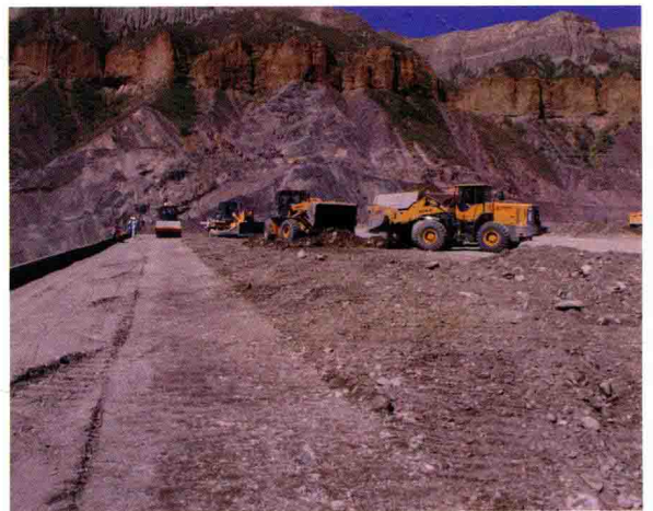
新疆肯斯瓦特水利枢纽工程混凝土面板坝砂砾石填筑
