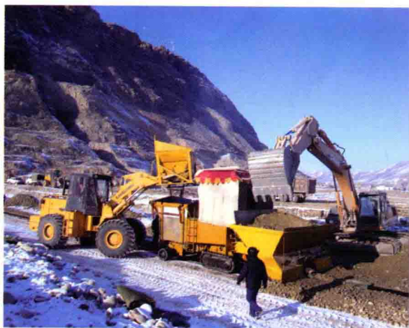
新疆库什塔依水电站沥青混凝土心墙堆石坝施工
