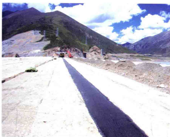
西藏旁多水利枢纽沥青混凝土心墙砂砾石坝施工
