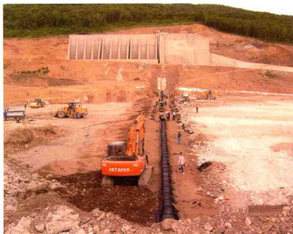
黑龙江五花山水电站沥青混凝土心墙土石坝基座处理
