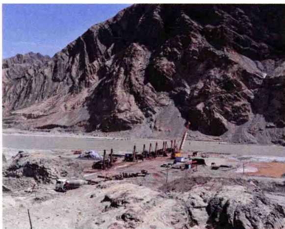
新疆阿尔塔尔水电站混凝土面板坝深覆盖防渗墙地基处理
