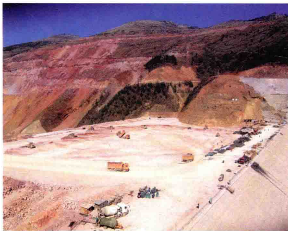
新疆石门水利枢纽工程混凝土面板堆石坝填筑施工
