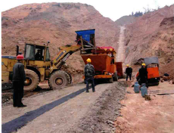
新疆公墓志水电站沥青混凝土心墙土石坝施工
