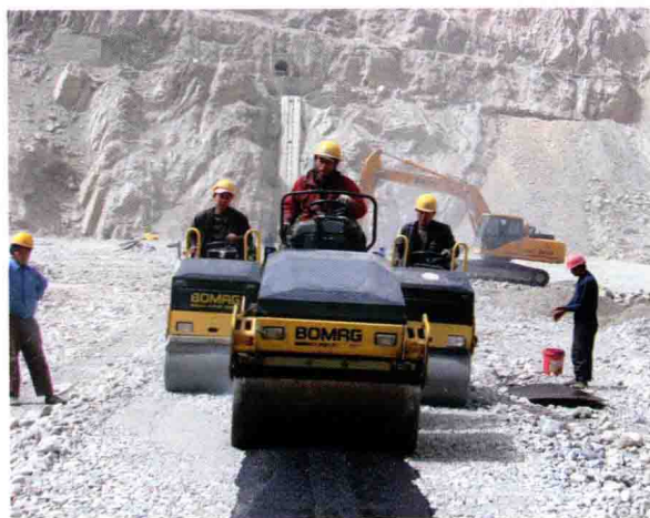
新疆下坂地水利枢纽工程沥青混凝土心墙碾压施工
