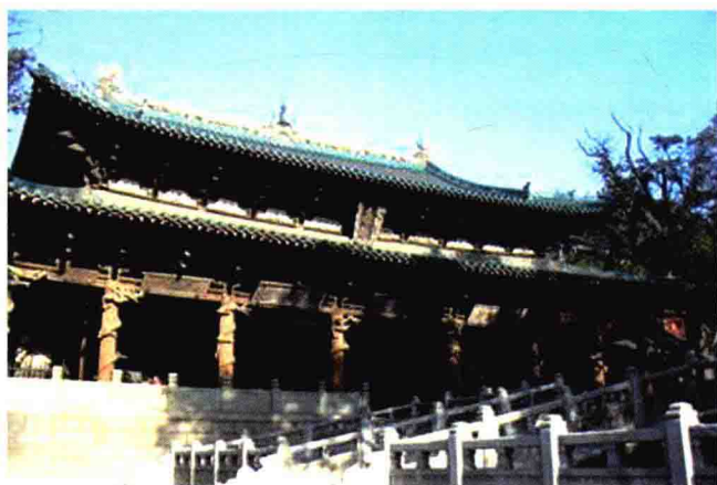
图 0-4 山西晋祠圣母殿，北宋遗存建筑，屋顶略显陡峭
