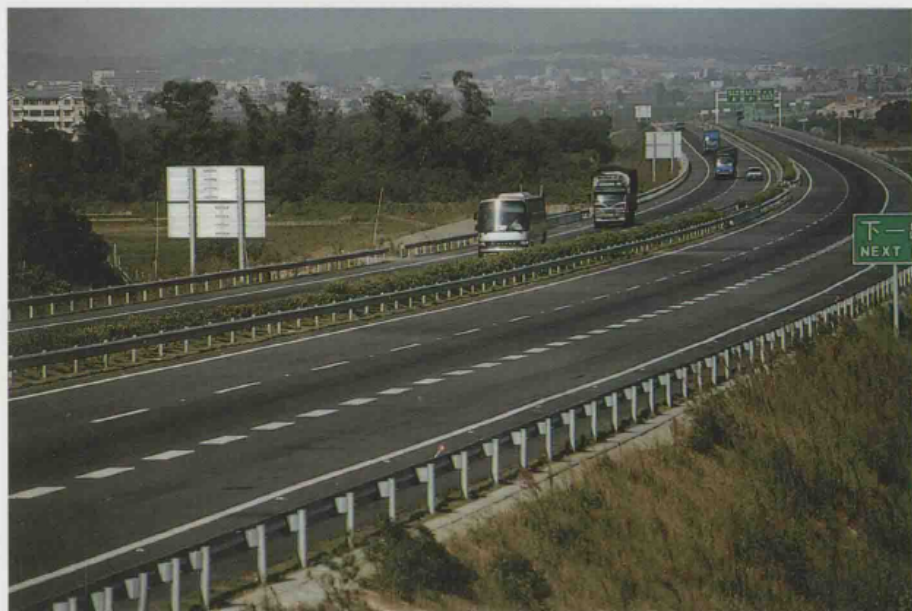
福厦高速公路晋江路段
