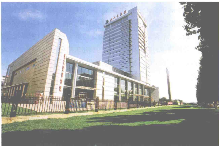
和总局办公大楼一体的北大荒博物馆
