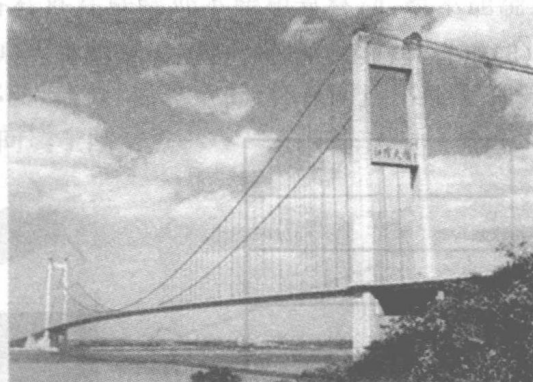
图1-9 江阴长江公路大桥(悬索桥 1385m)
