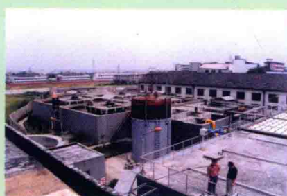
● 杭州中策啤酒(股份)有限公司 8000m 3 /d 废水处理工程
