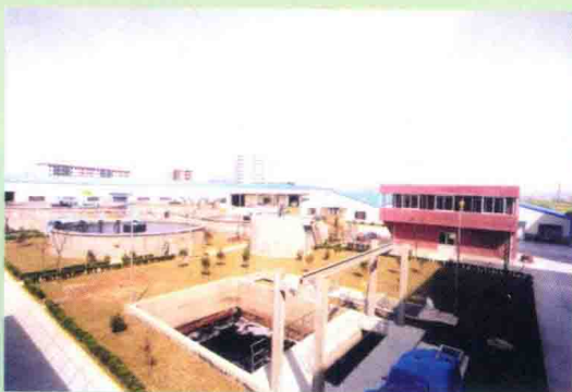
● 宁波申洲织造集团有限公司 10000m 3 /d 染整废水处理工程
