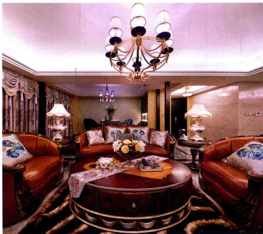
石膏板造型暗藏灯带
