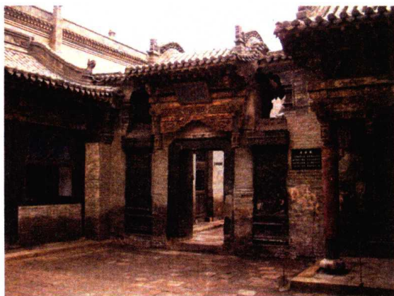
图 1-2 山西乔家大院的院落空间
