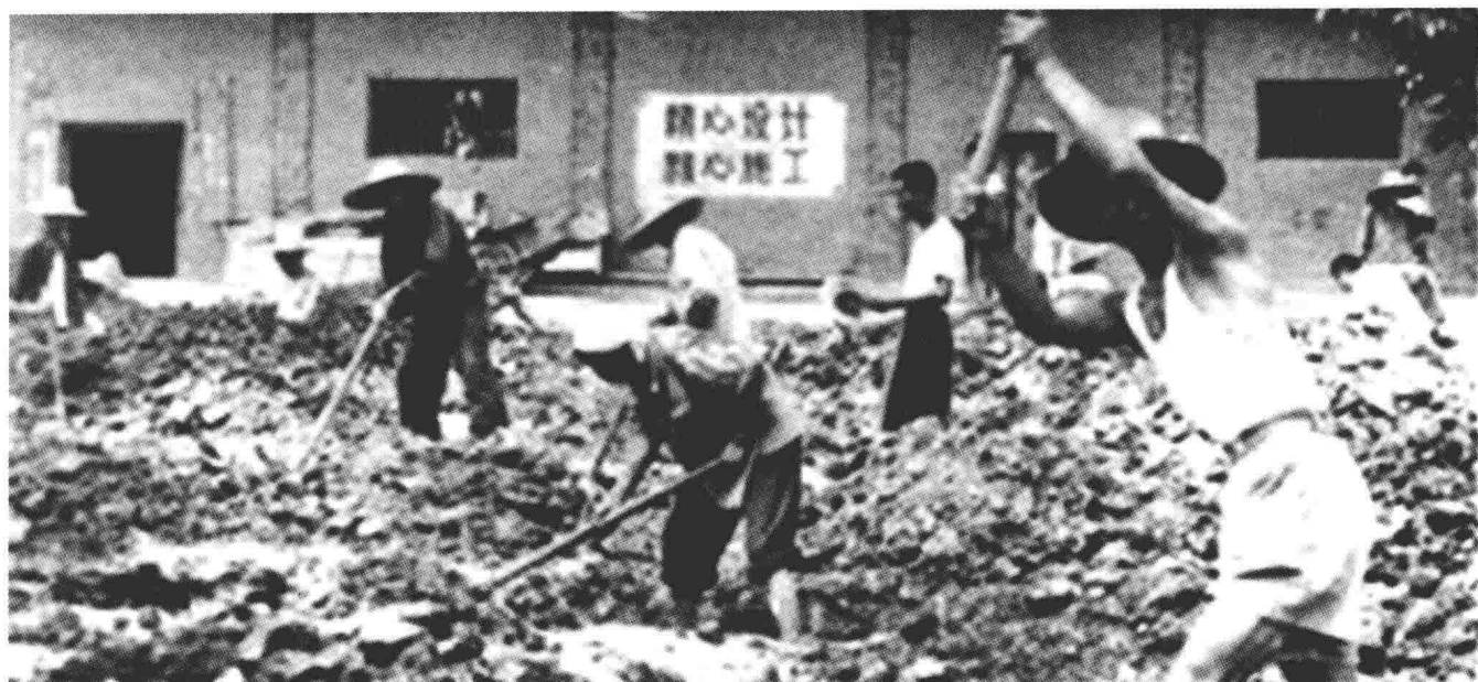
总装试飞厂的职工们挥镐扬锹，平整土地，为建设厂房做准备
