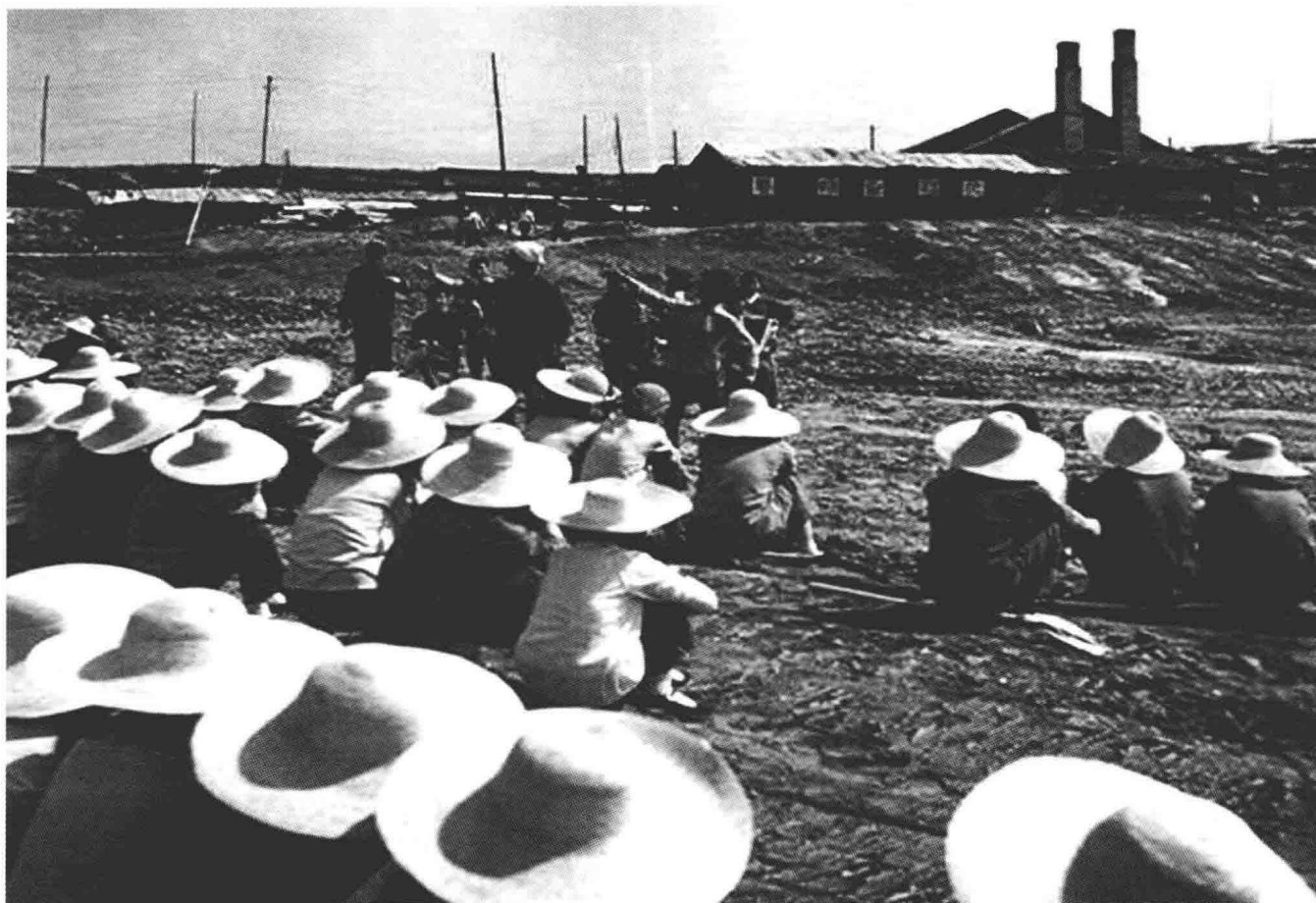
工地上的慰问演出
