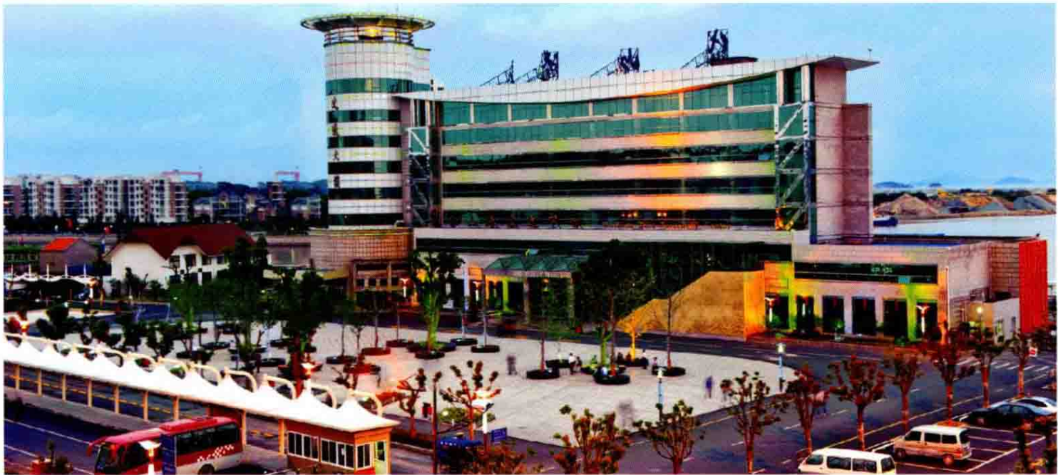
■ 2010 年,岱山港客运中心改造完工
