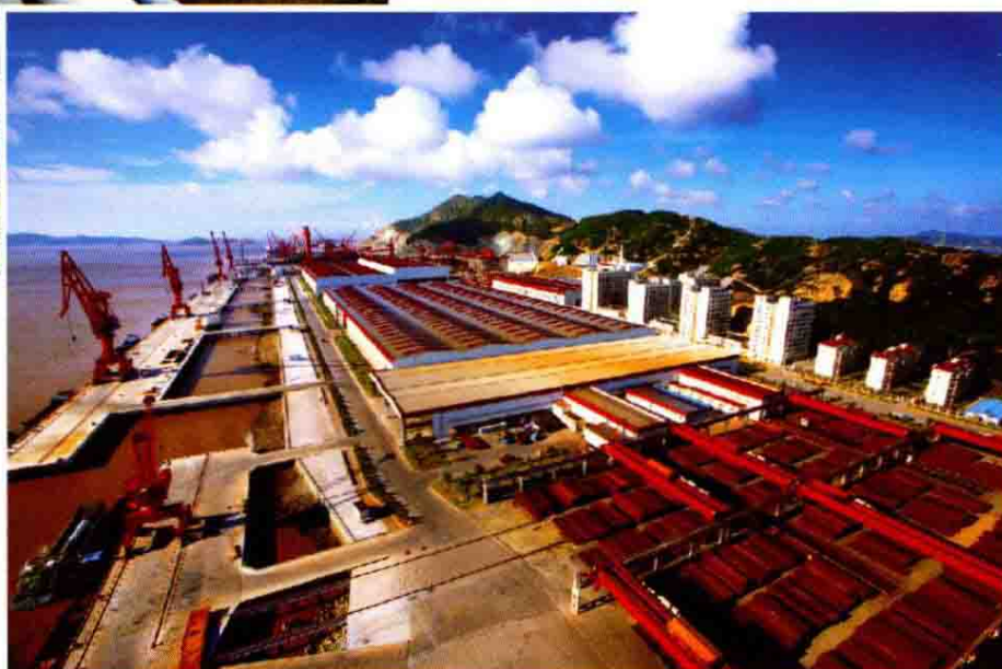
■ 金海重工舾装码头
