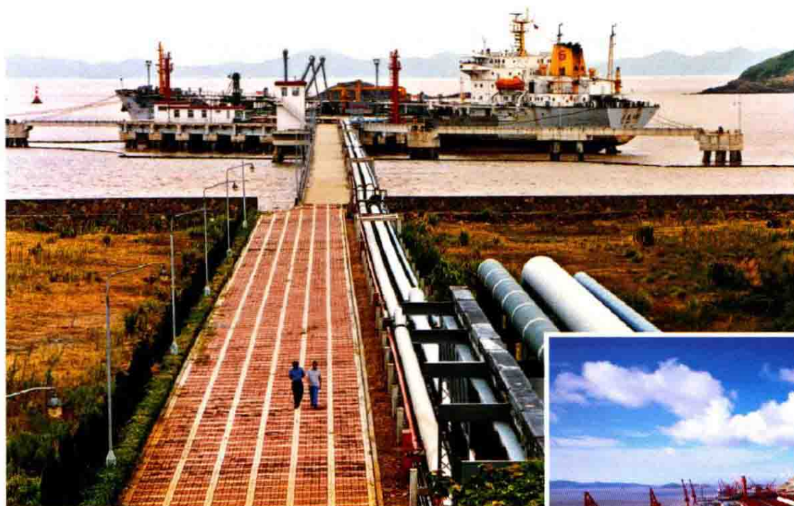
■ 东海平湖油气田岱山2.5万吨级原油中转码头
