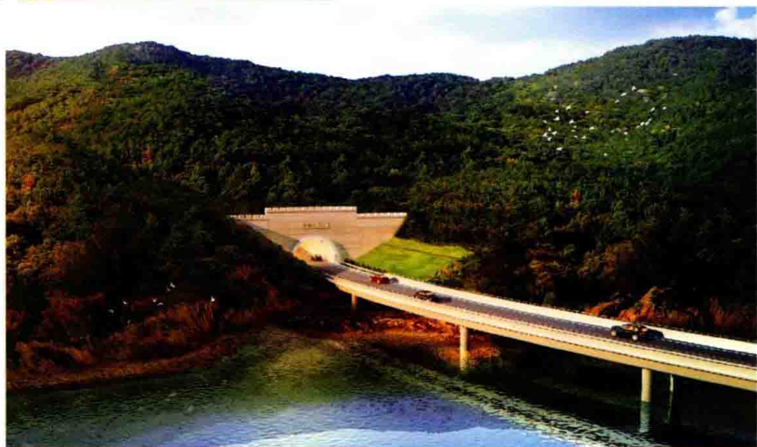
■ 燕窝山公路隧 道工程(在建)
