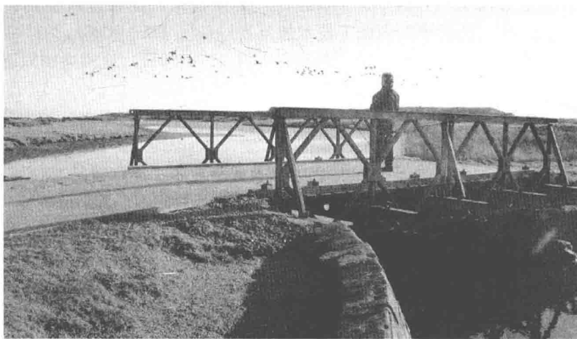
图 1.9 早期装配式公路钢桥(跨越 Ma Sillars 海峡的装配式公路钢桥)
