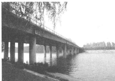
图 1.6 周口市东沙河大桥提载加固前全貌
