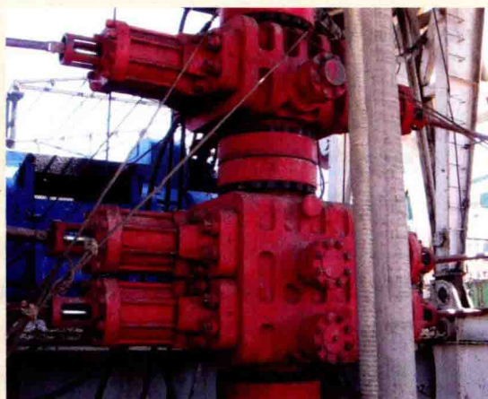
图 1-1-10 旁侧孔面向井架大门 (图二)
