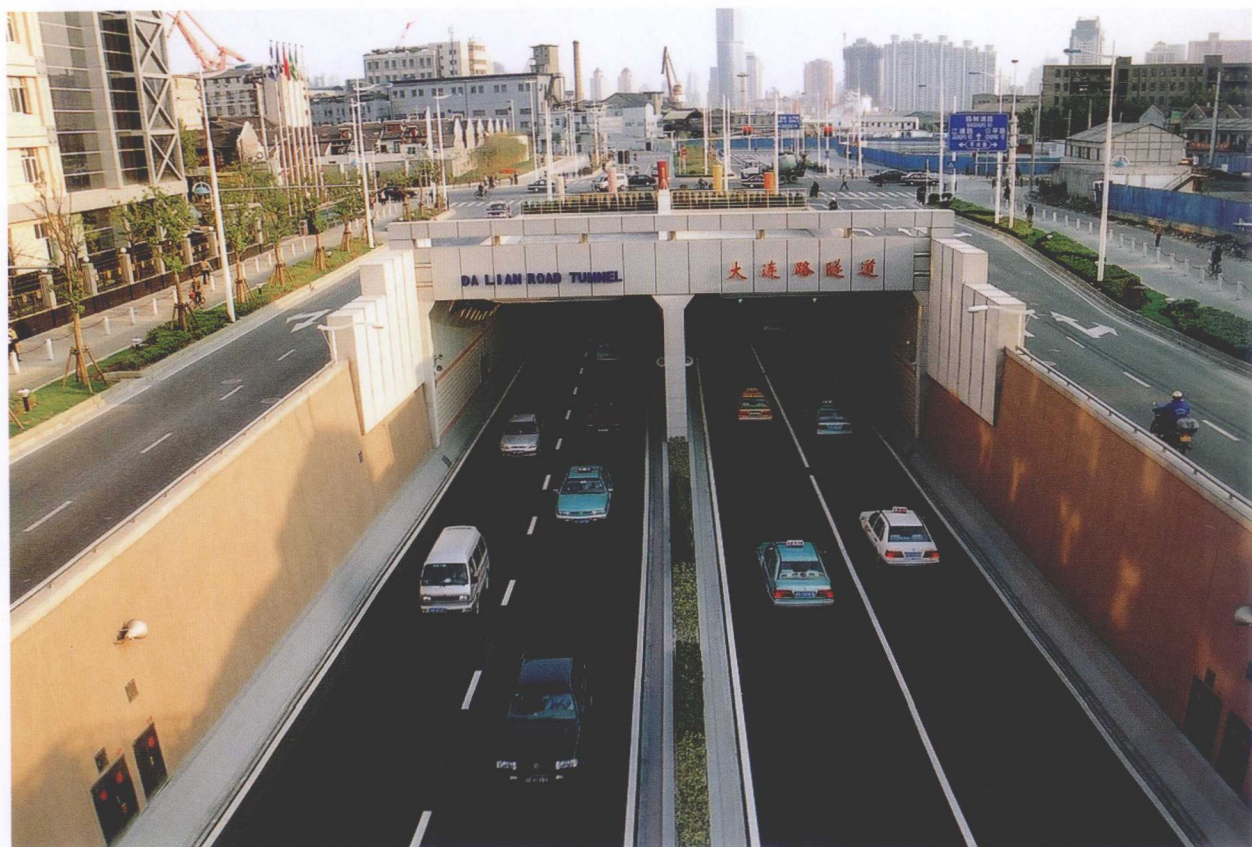
9月29日，上海第四条越江公路隧道——大连路隧道建成通车
