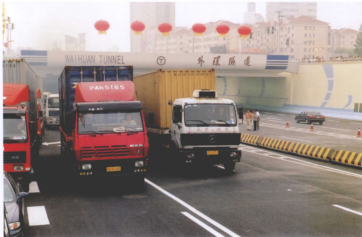
6月21日，中国第一条采用沉管法施工的越江隧道——上海外环隧道建成通车
