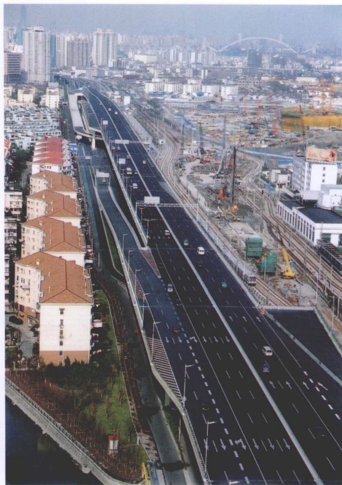
12月28日，市重点工程——沪闵路高架二期工程竣工通车
