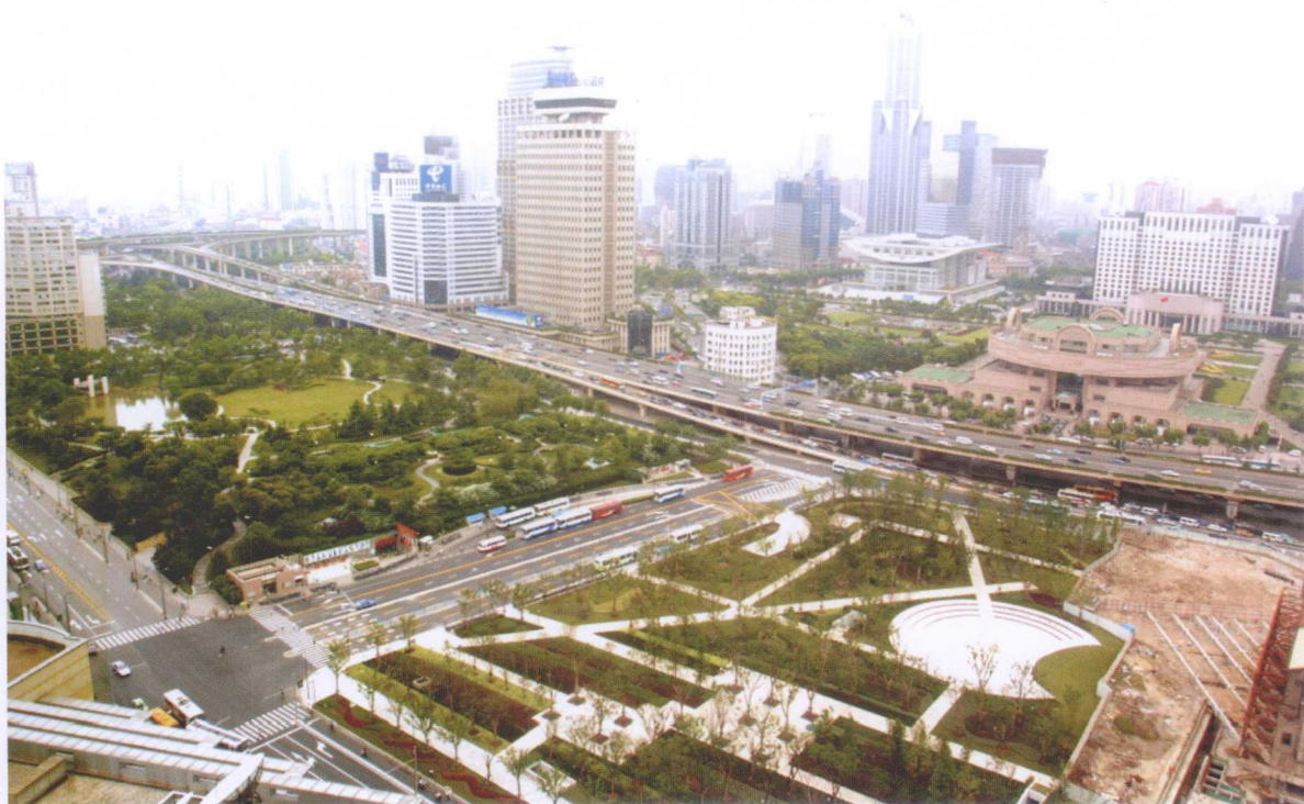
10月底，广场公园绿地三期工程竣工
