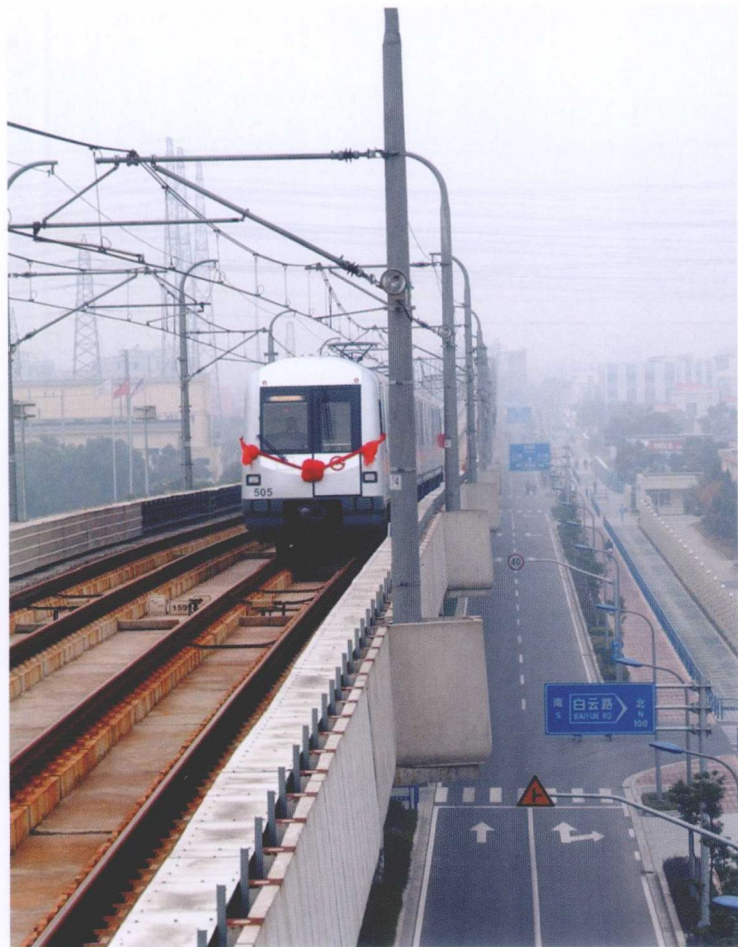
11月25日，轨道交通五号线开通试运营
