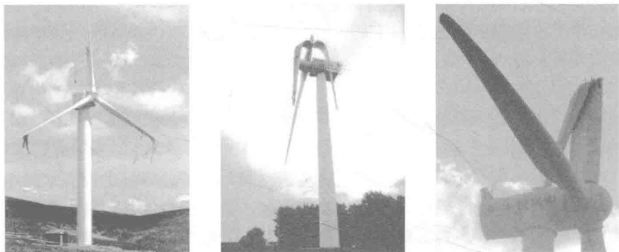
图 1.3 风力发电机叶片损伤
